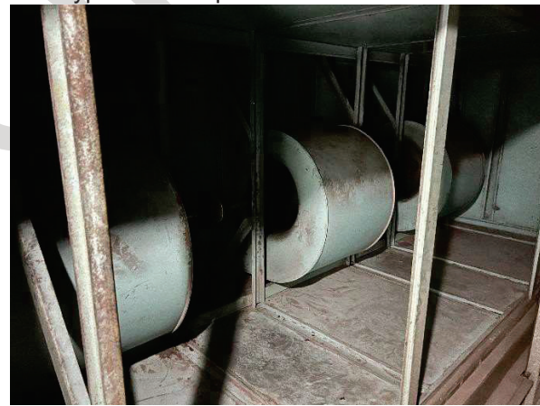
M10 – existing air handler centrifugal fan
